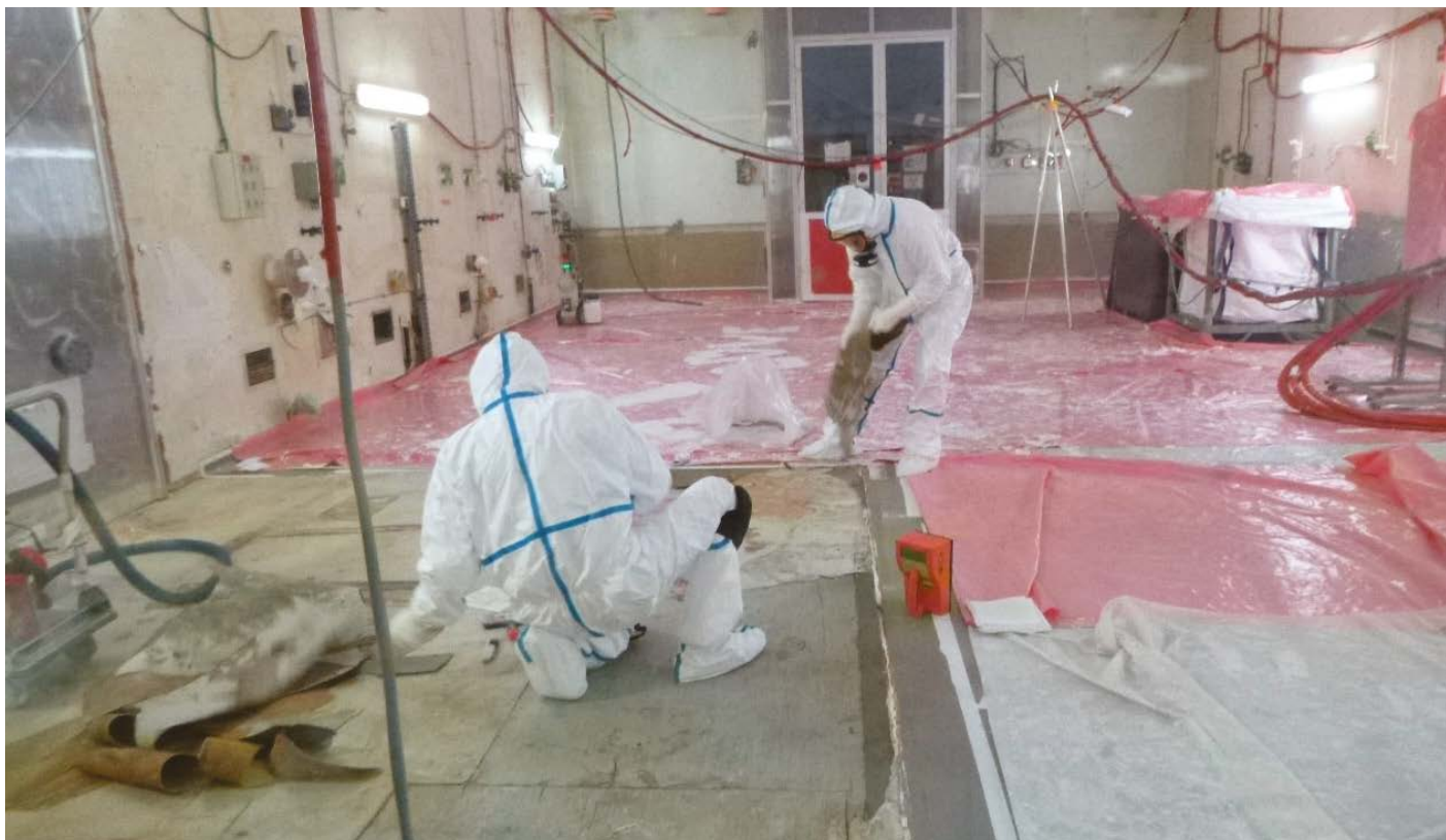
Désamiantage d'un laboratoire bâtiment 18. ©CEA-UADF
