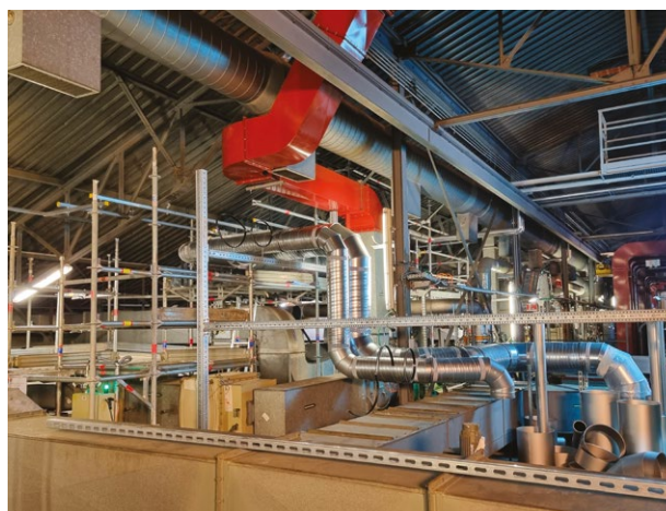
Montage de la nouvelle ventilation de Petrus. ©CEA – UADF
