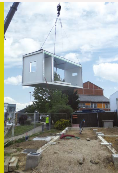
Photo de couverture : Des bâtiments ont été aménagés pour permettre de poursuivre des travaux INB 166 dans de bonnes conditions de sécurité et d'hygiène.
