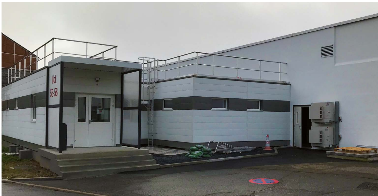
Les vestiaires en voie d'achèvement.
