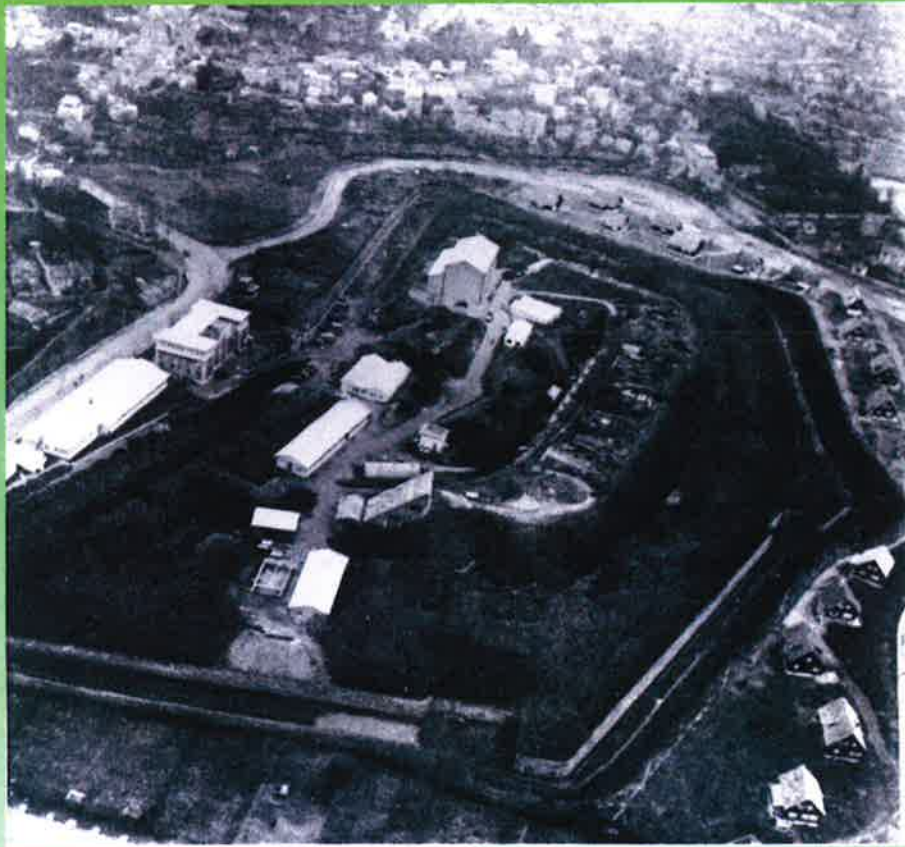
Vue aérienne du site CEA/FAR en 1950
