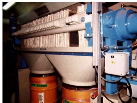
Figure 16 -Station SABINE de production des boues
