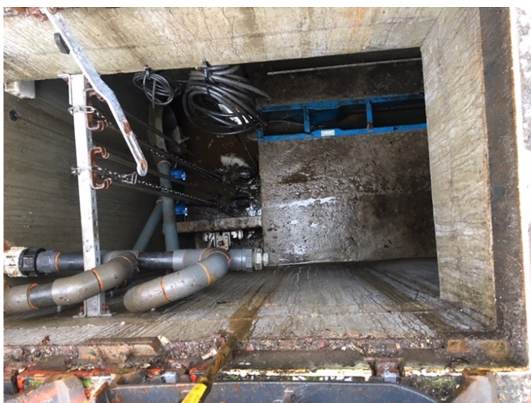
Figure 18 - Point de surveillance des effluents de l'émissaire 17 avant rejet dans l'égout urbain
